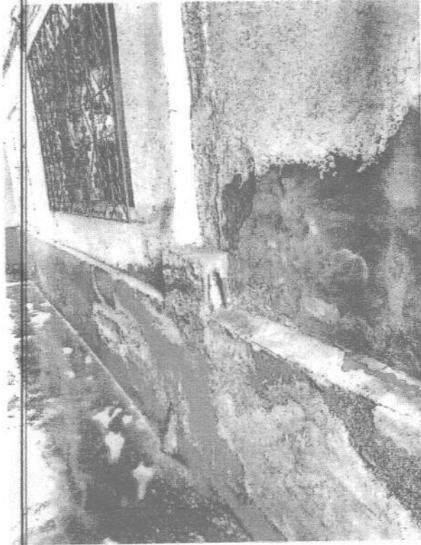
Foto 16: descascamento pintura - 24/05/2021
