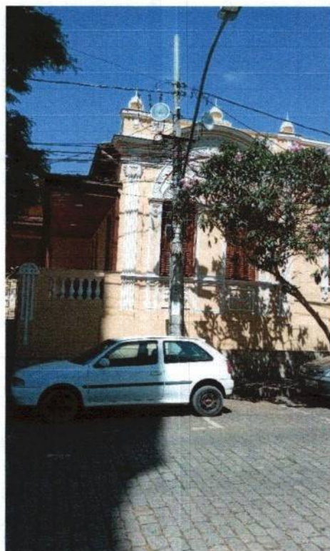
FOTO 10 – Poste Lateral Esquerda, 1 Pétalas de led, 2 Refletores com Reator.(Poste P5)
