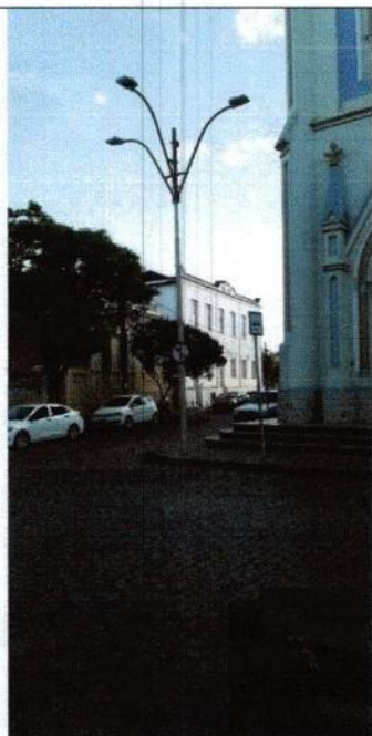
FOTO 3 – Poste frontal. (Poste P6)
