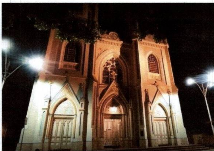
Figura 6 – Foto da fachada principal da igreja com a atual iluminação
