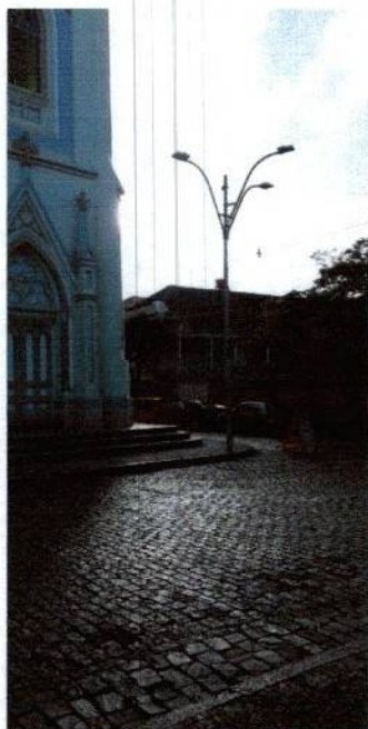
FOTO 5 – Poste frontal , 3 Pétalas, Led (poste P6) Foto retirada lateral direita. (Poste P7) Alimentação atual vem do P9
