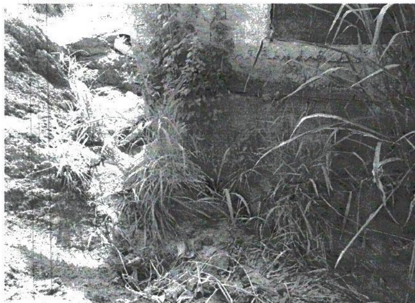
Foto 4 - Detalhe para a erosão causada pelo fluxo das águas superficiais adjacente à edificação em construção.
