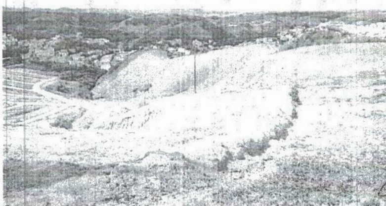
Figura 4: Vala criada recentemente tirando o fluxo d'água do talude erodido
