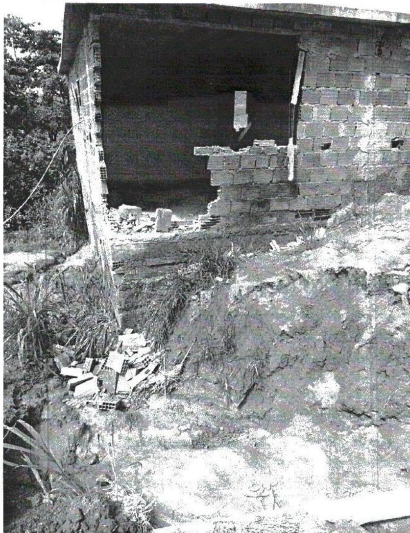
Foto 6 - Patologias observadas na estrutura da edificação em construção relacionadas à movimentação do terreno.
