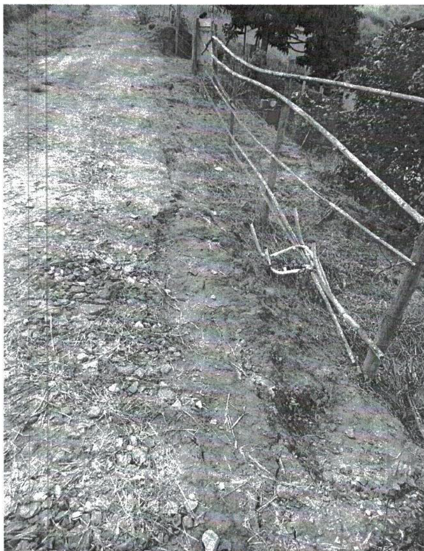
Foto 3 – Trincas observadas na lateral da Rua Paulo Moreira Brandão, a montante das 3 edificações avaliadas.
