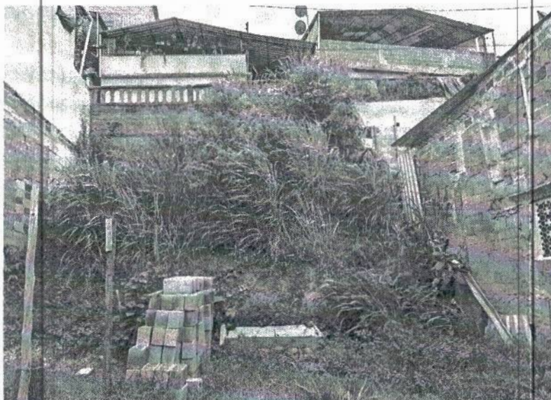
Figura 3 Lote ao lado onde será depositado os materiais e onde passará a rede de drenagem do muro à rua
