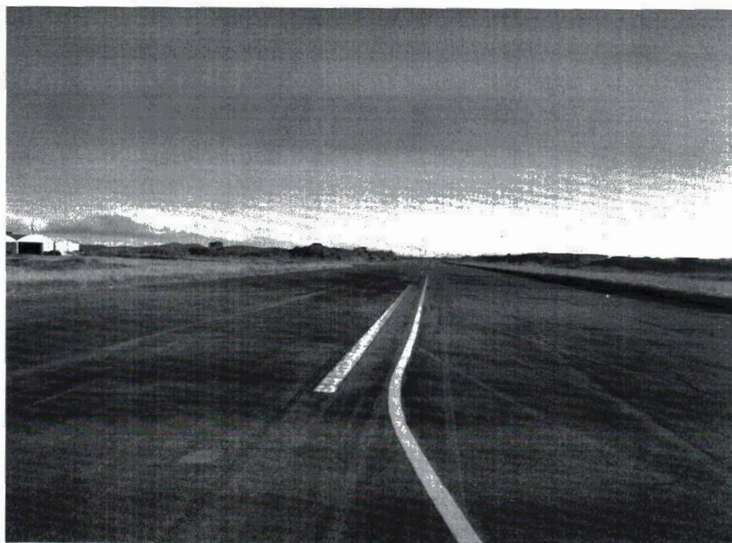
Pintura da Pista
