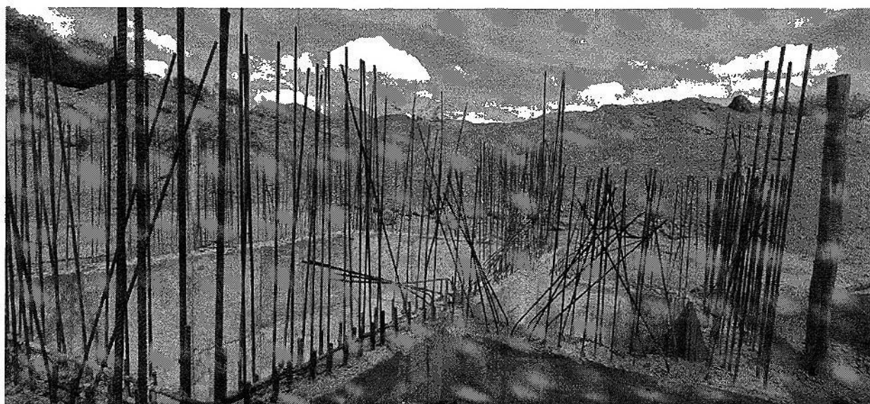
Figura 4: Estação elevatória margem direita
