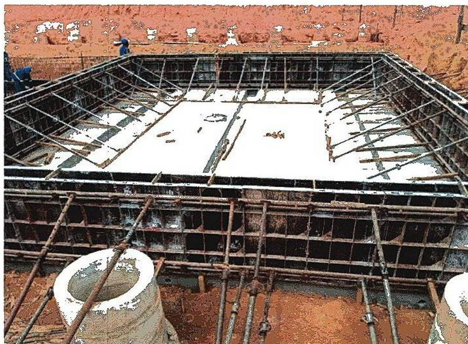
Figura 2: Escoramento Leito de secagem
