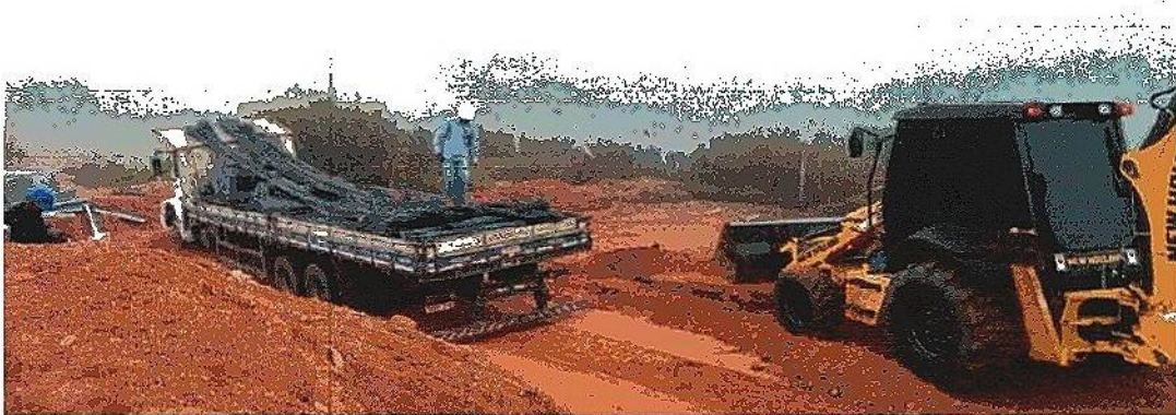
Figura 6: Carregamento de aço chegando em obra
