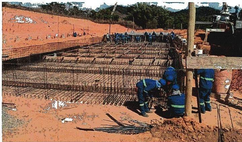
Figura 1: Armação de estrutura do leito de secagem
