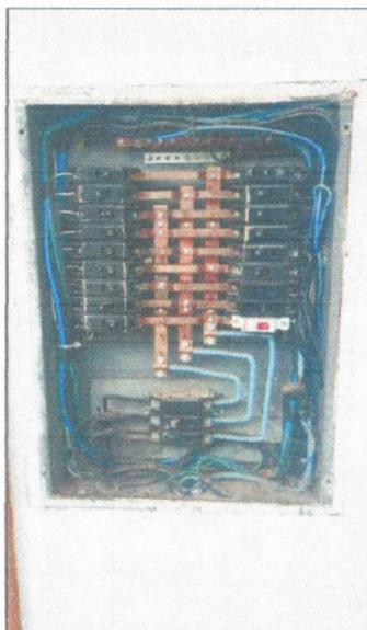
**Painel Elétrico 2:** Painel apresenta barramento danificado, falha na isolação do condutor neutro, sujeira excessiva, desorganização, elementos soltos, falta condutor terra e conexões falhas (sem terminais).
