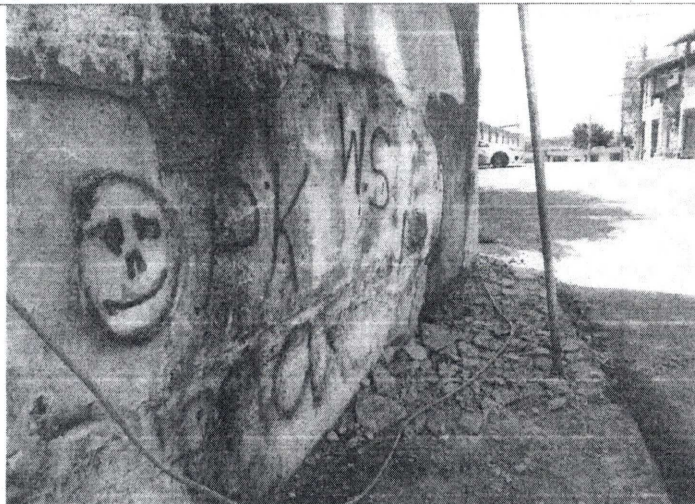
Foto 03/08: RETIRADA REBOCO SOLTO (SÃO PEDRO).
