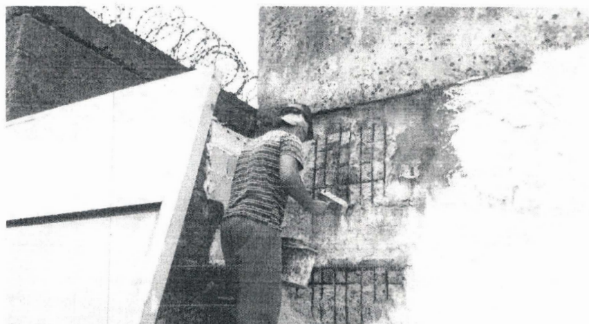
Foto 04/06: TRATAMENTO ARMADURA EXTERNA APARENTE, TRATAMENTO, FISSURAS E TRINCAS RECOMPOSIÇÃO E REFORÇO ARMADURA
