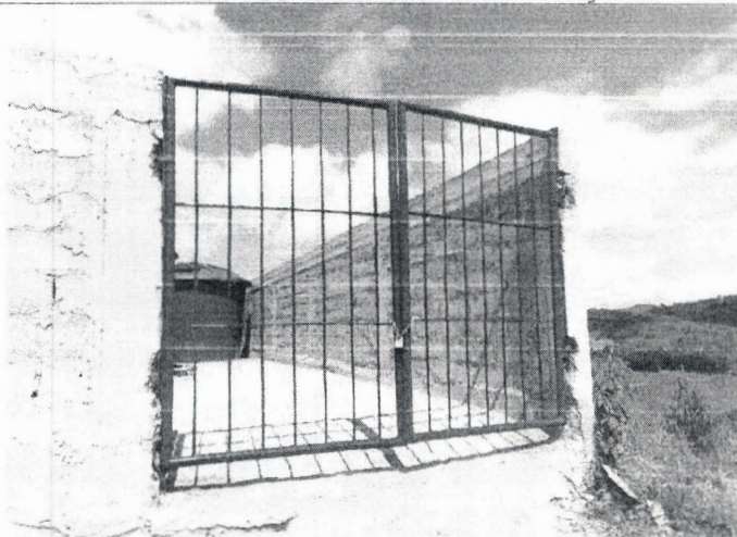
Foto 01/08: PORTÃO EM TUBO GALVANIZADO Ø ½ TRINCO E CADEADO
