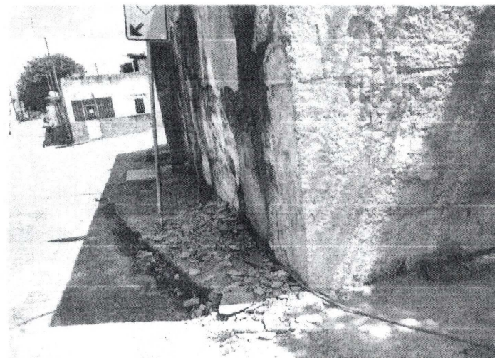
Foto 04/08: RETIRADA REBOCO SOLTO (SÃO PEDRO).
