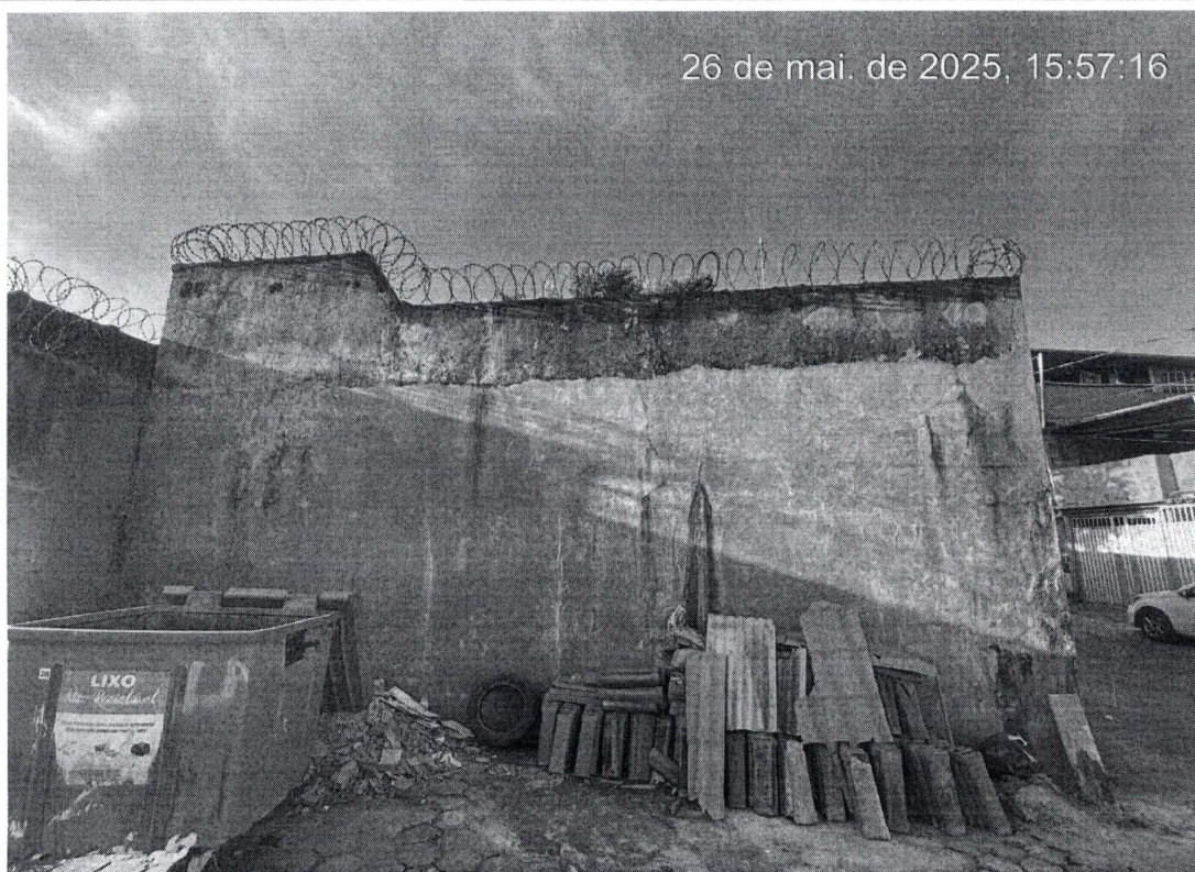
Figura 1 – Reservatório do Bairro São Pedro.
