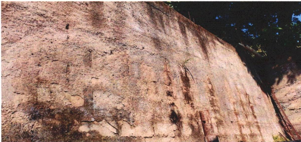
Imagem 2 - Vista frontal do muro.
