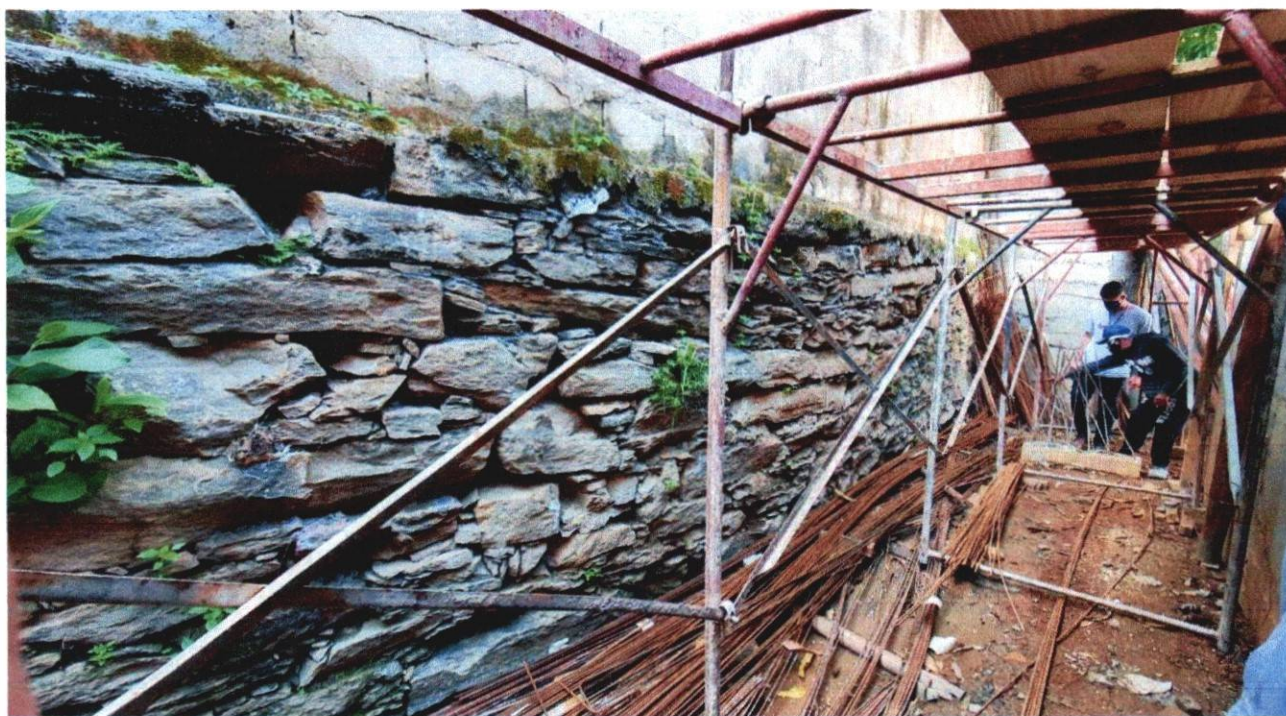
Imagem 1 – Vista Frontal do “muro de pedras”.
