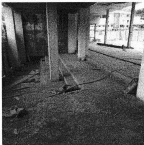
CONTRAPISO EM ESCADA
