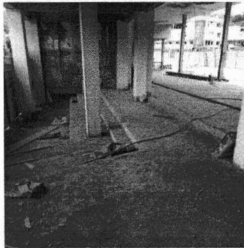
CONTRAPISO EM ESCADA
