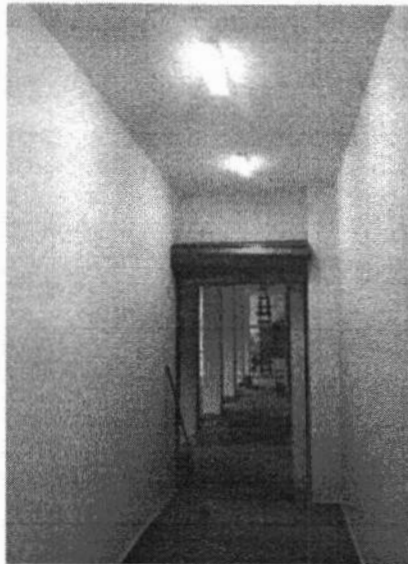
PORTA DE AÇO / LUMINÁRIAS / PINTURA
