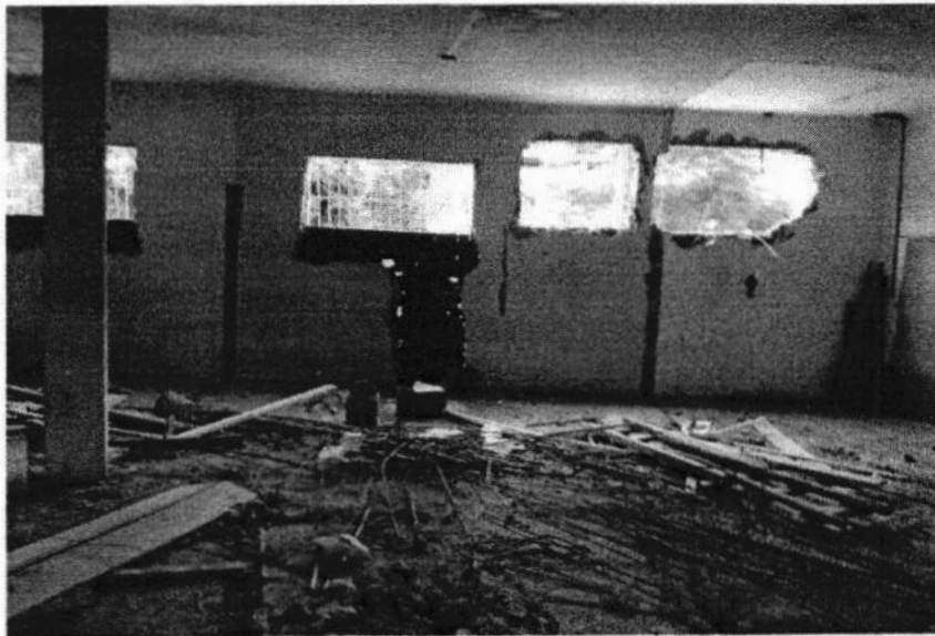
DEMOLIÇÃO DE ALVENARIA
