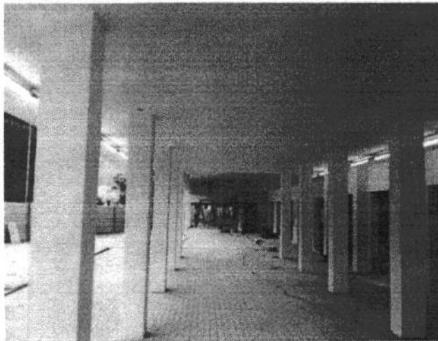
PINTURA PAREDE / PINTURA TETO
