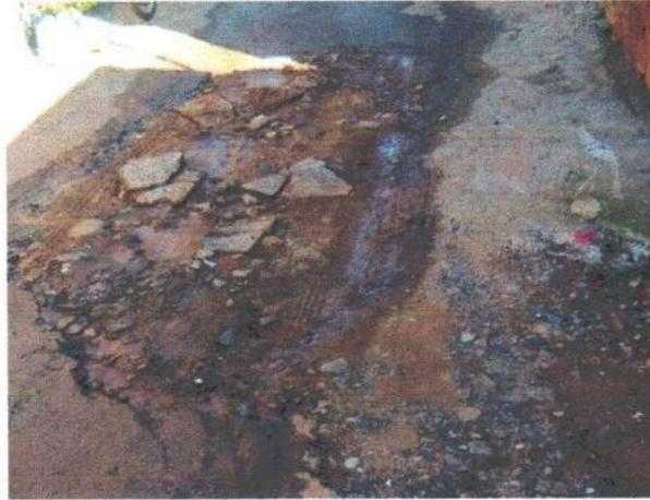
***Figura 2 – Trecho Necessitando Recomposição de Asfalto na Rua do Campo***
