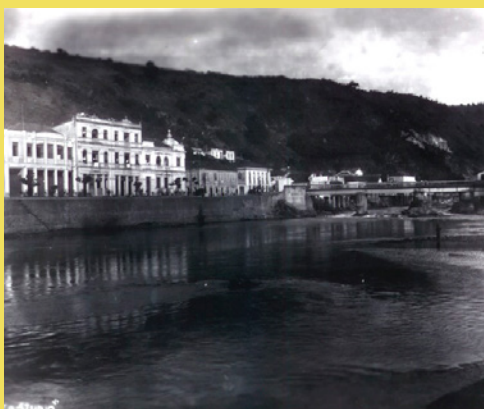
Década de 20-30 - R. Arthur Bernardes-Déc.1930-A ponte Arthur Bernardes de concreto armado projetada pelo engenheiro Bello Lisboa
