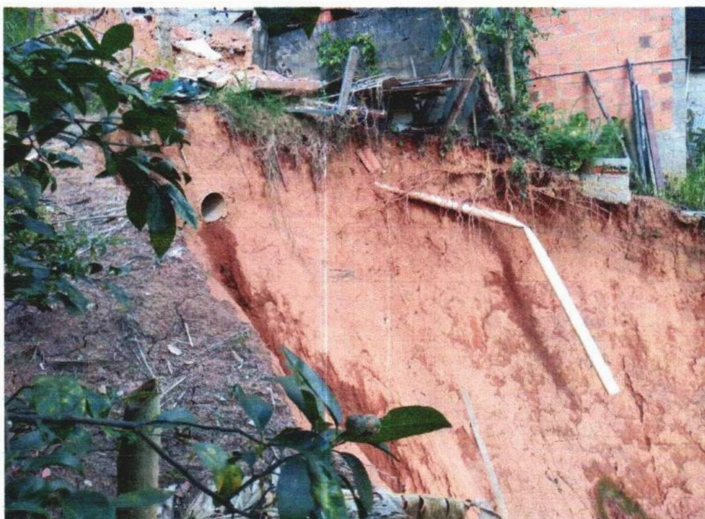
Figura 3: Detalhe manilha de água pluvial no ponto onde ocorreu rompimento do talude
