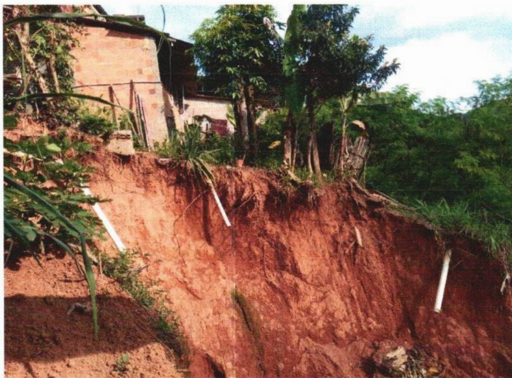
Figura 2: Tubulação de esgoto danificada e suspensa.
