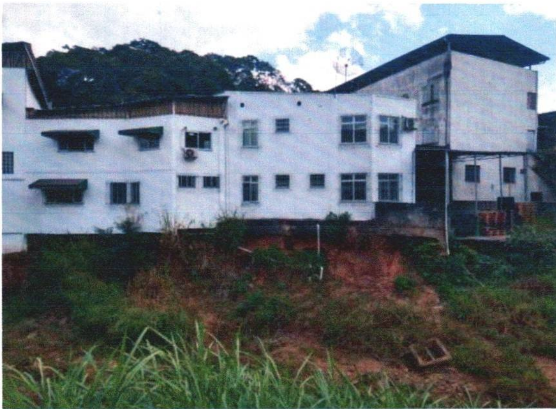
Figura 12: Vista ampla das edificações nas encostas
