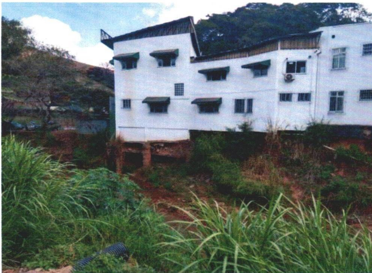
Figura 9: Fundação exposta
