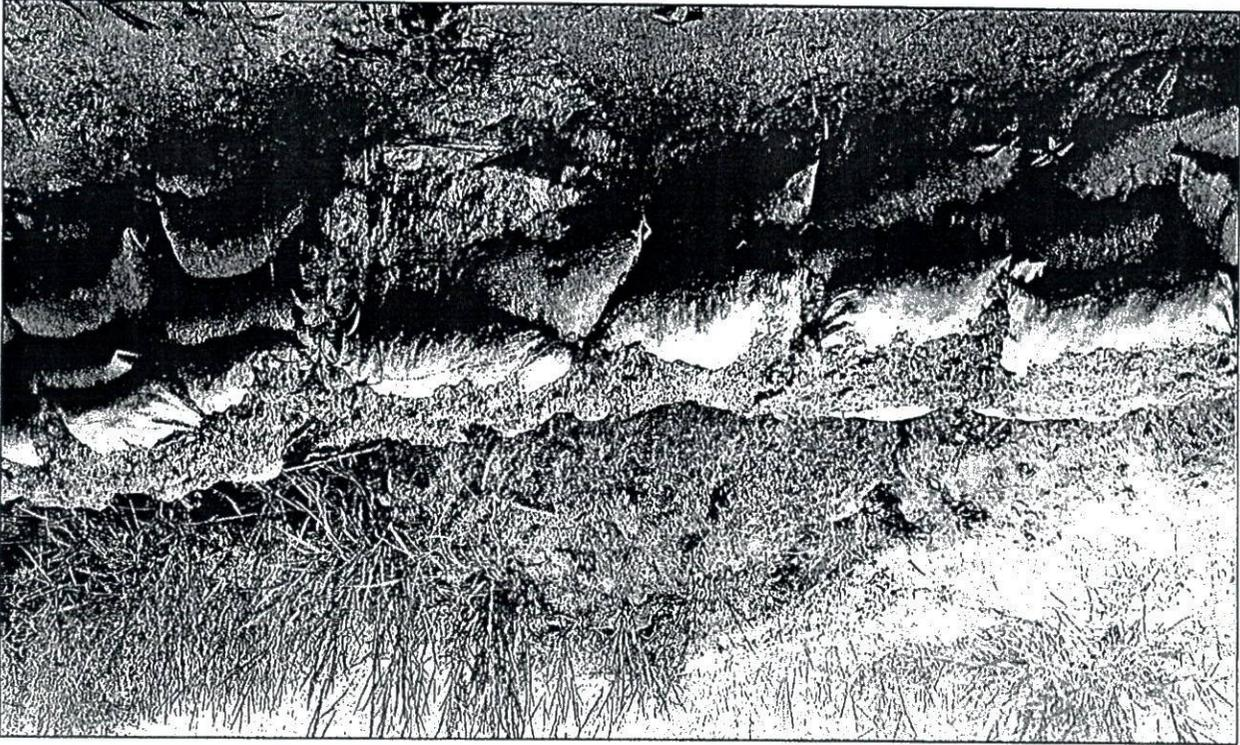
Imagem 04: Talude existente, apresentando trincas e evidenciando movimentação de massa.
