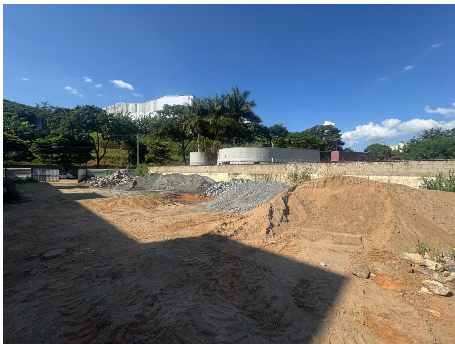
Foto 4 – Vista interna do lote.
