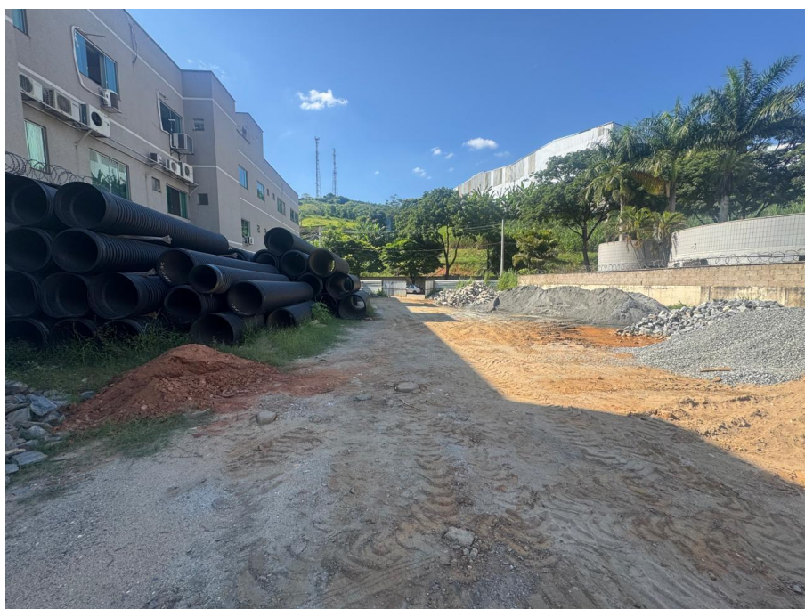
Foto 5 – Vista interna do lote.
