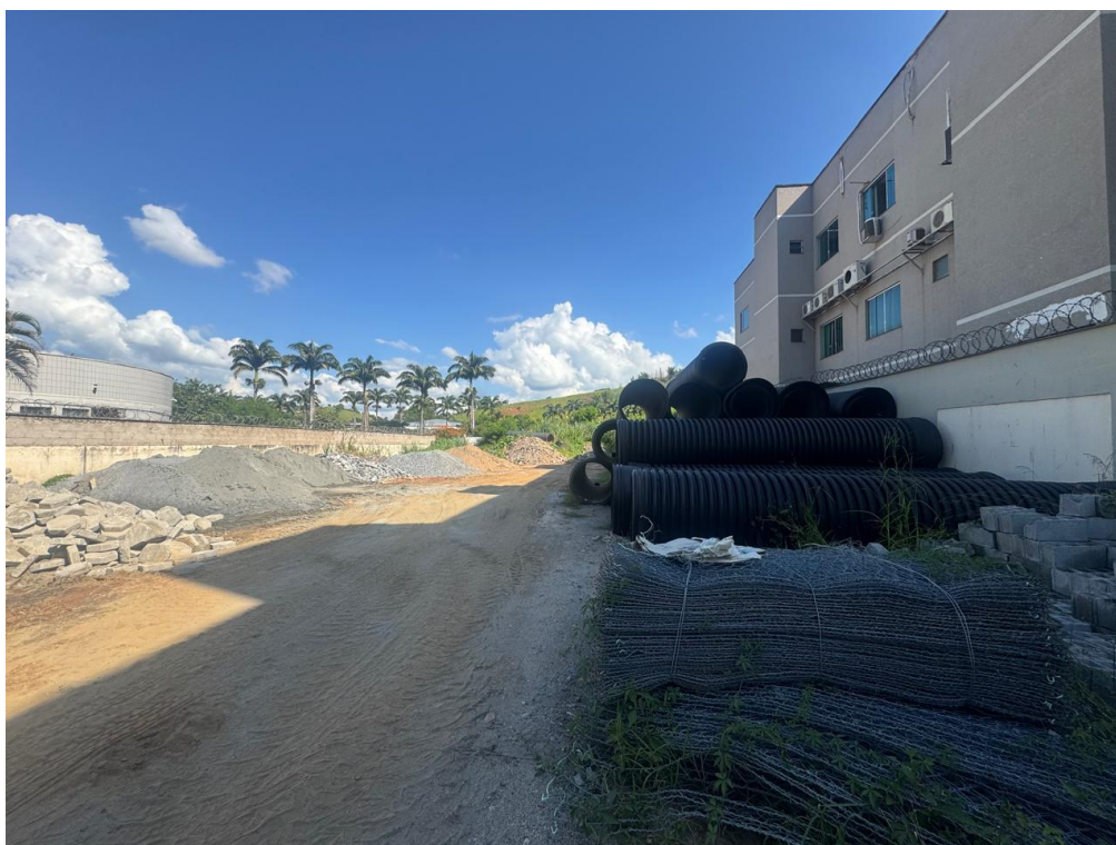
Foto 3 – Vista interna do lote.
