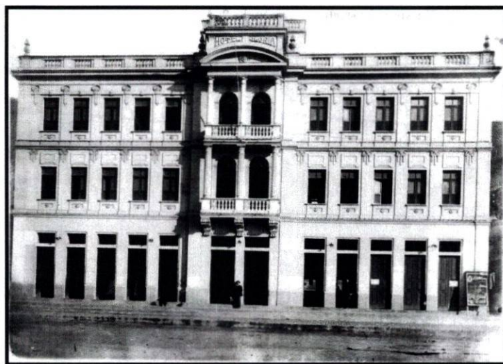
Figura 1: Hotel Glória, marco do crescimento econômico de Ponte Nova.
