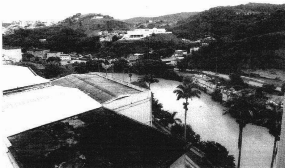
Foto 197 - Edificações construídas em trecho suscetível a processos de solapamento. Rua Antônio Frederico Ozanan com Santa Teresinha.
