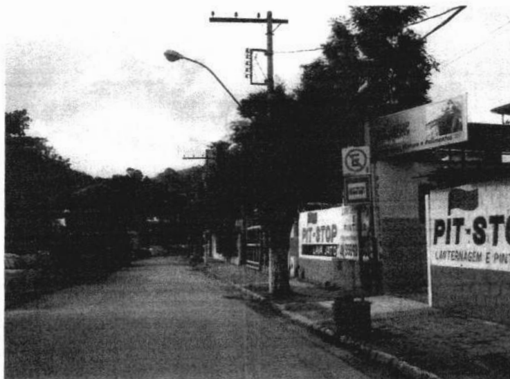
Foto 215 - Rua Doutor Artur Bernardes. Vista de parte da planície aluvionar ocupada do Rio Piranga. Área naturalmente suscetível a processos de inundação que alcançam neste trecho até 3,0m acima da cota de transbordamento da calha.
