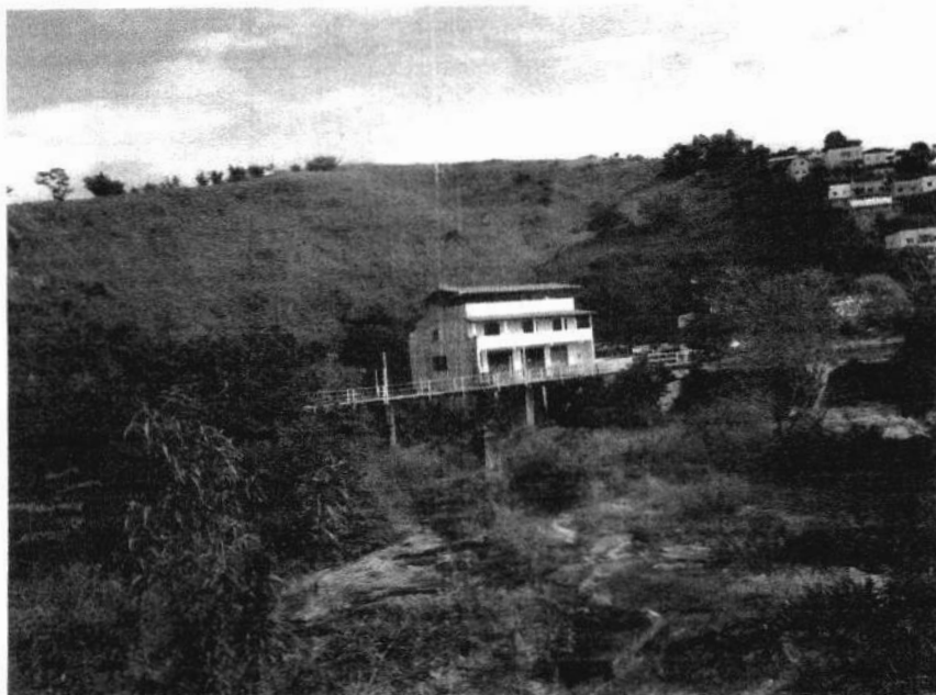
Foto 192 – Edificação construída dentro do leito do Rio Piranga em trecho de influência deste. Durante os períodos de chuva e enchentes o Rio engloba por completo a edificação. Área não edificante.
