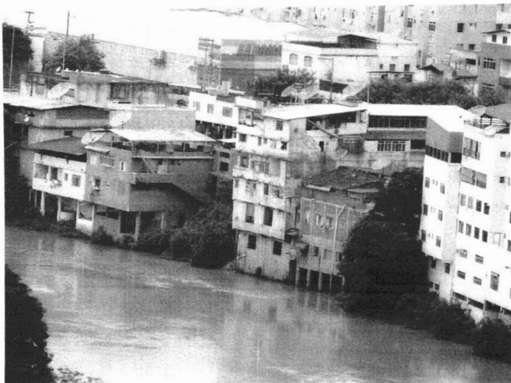
Foto 202 – Vista aproximada em relação a foto anterior. Domicílios construídos em trecho suscetível a processos de solapamento. Estruturas construídas dentro da área de influência do Rio Piranga. Foto obtida no período seco.
