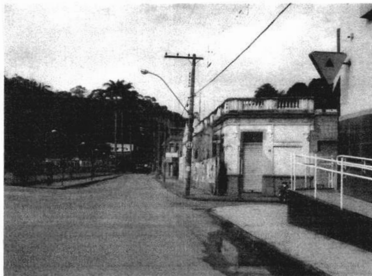
Foto 217 - Rua Doutor Artur Bernardes. Vista de parte da planície aluvionar ocupada do Rio Piranga. Área naturalmente suscetível a processos de inundação que alcançam neste trecho até 3,0m acima da cota de transbordamento da calha.
