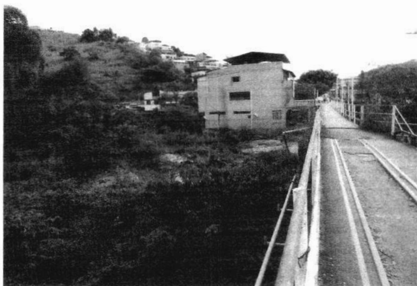
Foto 193 – Vista do mesmo domicílio da foto anterior a partir da passarela da Rua Copacabana. Destaque para o leito rochoso do Rio Piranga sobre o qual a edificação foi construída.
