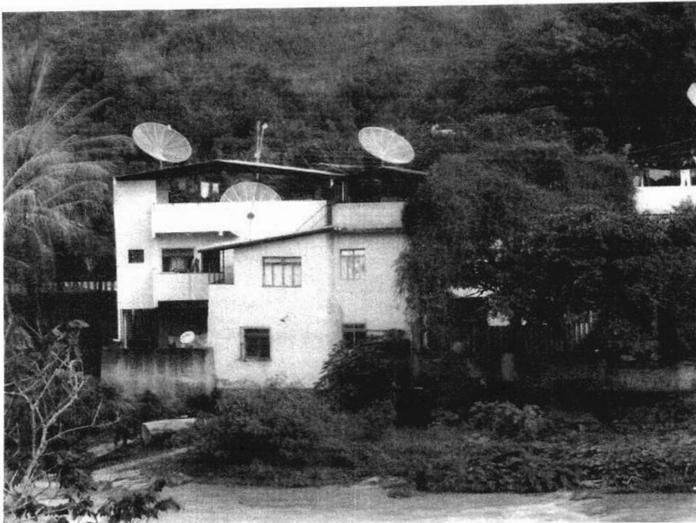
Foto 200 – Destaque para as marcas na parede do domicílio de atingimento das cheias do Rio Piranga, o que corrobora para a classificação do risco em relação a processos de solapamento e inundação.
