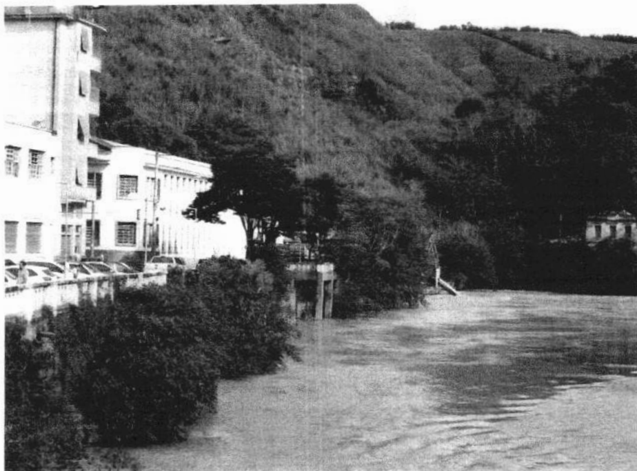
Foto 196 - Domicílios construídos em trecho suscetível a processos de solapamento, Rua João Pinheiro próximo ao Banco do Brasil.
