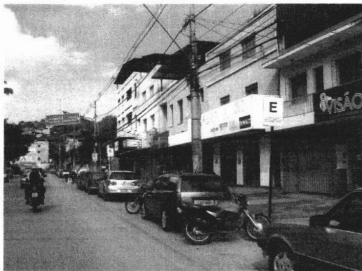
Foto 218 - Rua Doutor Artur Bernardes. Vista de parte da planície aluvionar ocupada do Rio Piranga. Área naturalmente suscetível a processos de inundação que alcançam neste trecho até 3,0m acima da cota de transbordamento da calha.
