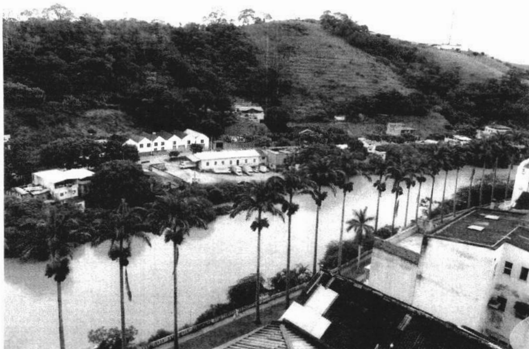
Foto 198 - Edificações construídas em trecho suscetível a processos de solapamento. Rua Santa Teresinha.
