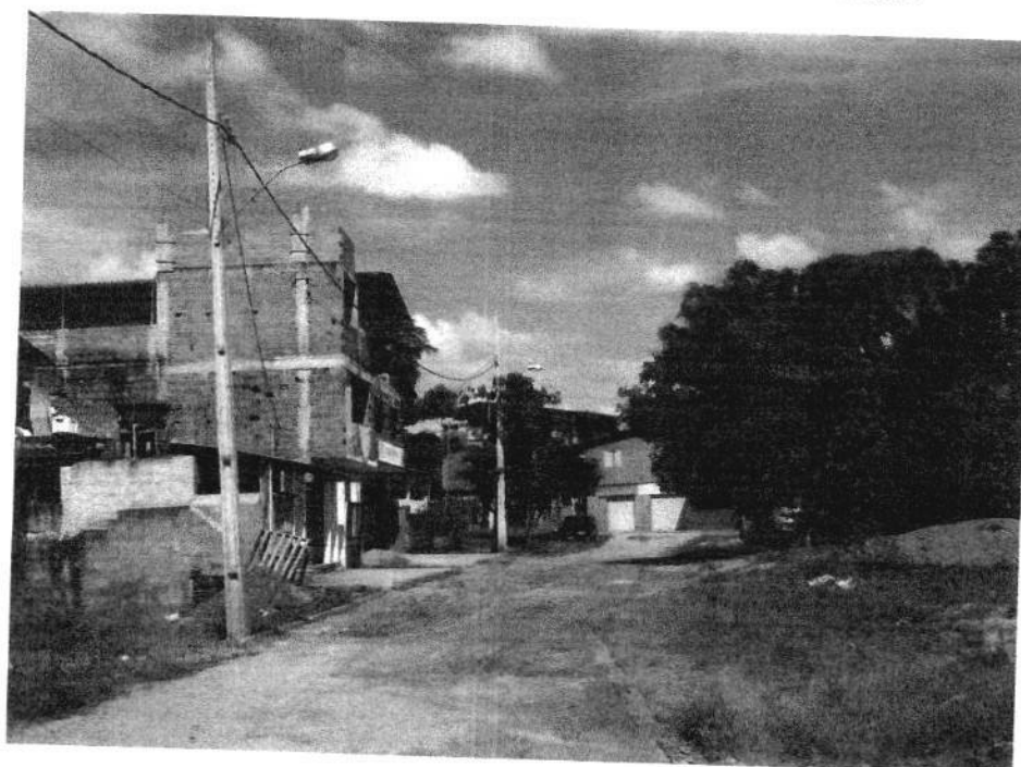
Foto 225 – Rua da Tábua. Trecho atingido pelas inundações no ano de 2018.
