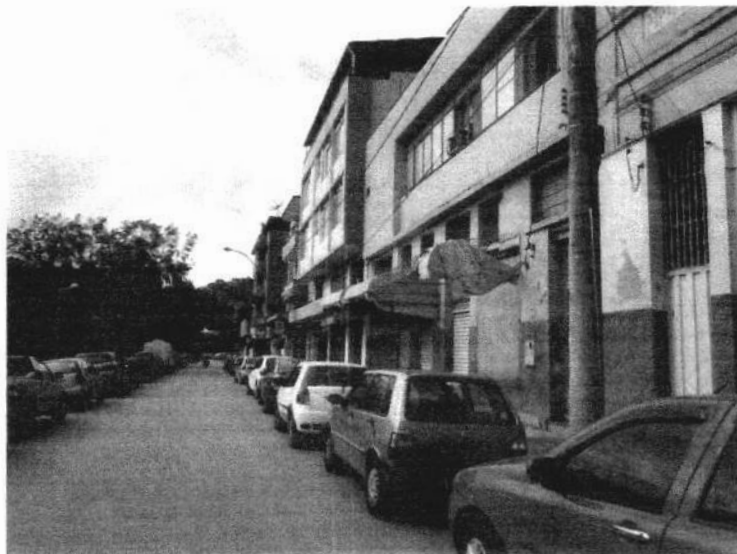
Foto 214 – Rua Doutor Artur Bernardes. Vista de parte da planície aluvionar ocupada do Rio Piranga. Área naturalmente suscetível a processos de inundação que alcançam neste trecho até 3,5m acima da cota de transbordamento da calha.
