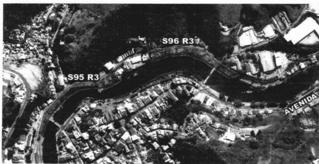
Figura 97 – Localização e delimitação do setor 95 de risco do PMRR.
