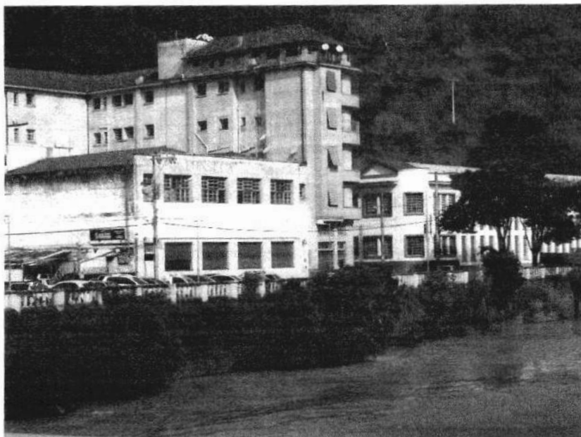
Foto 212 - Vista de parte da planície aluvionar ocupada do Rio Piranga. Área naturalmente suscetível a processos de inundação, que alcançam neste trecho até 3,5m acima da cota de transbordamento da calha.
