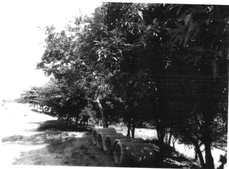
Foto 223 – Vista parcial do bairro Ana Florência, Rua da Tábua. Trecho sujeito a inundação em episódios de chuvas mais intensas e prolongadas.
