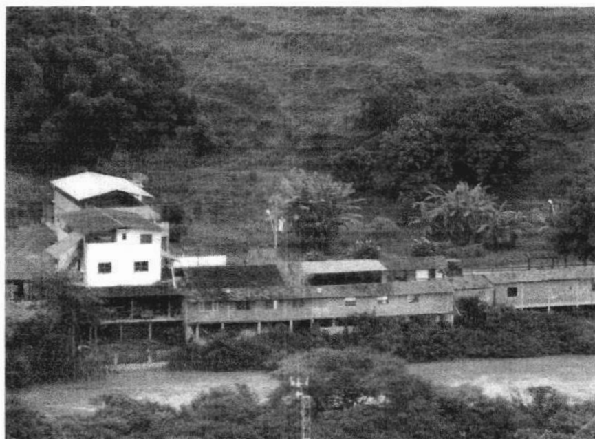
Foto 204 – Domicílios construídos em trecho suscetível a processos de solapamento. Estruturas construídas dentro da área de influência do Rio Piranga. Foto obtida no período seco.
