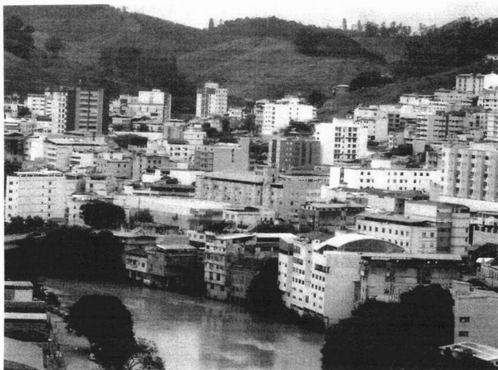
Foto 201 - Domicílios construídos em trecho suscetível a processos de solapamento. Estruturas construídas dentro da área de influência do Rio Piranga. Foto obtida no período seco.
