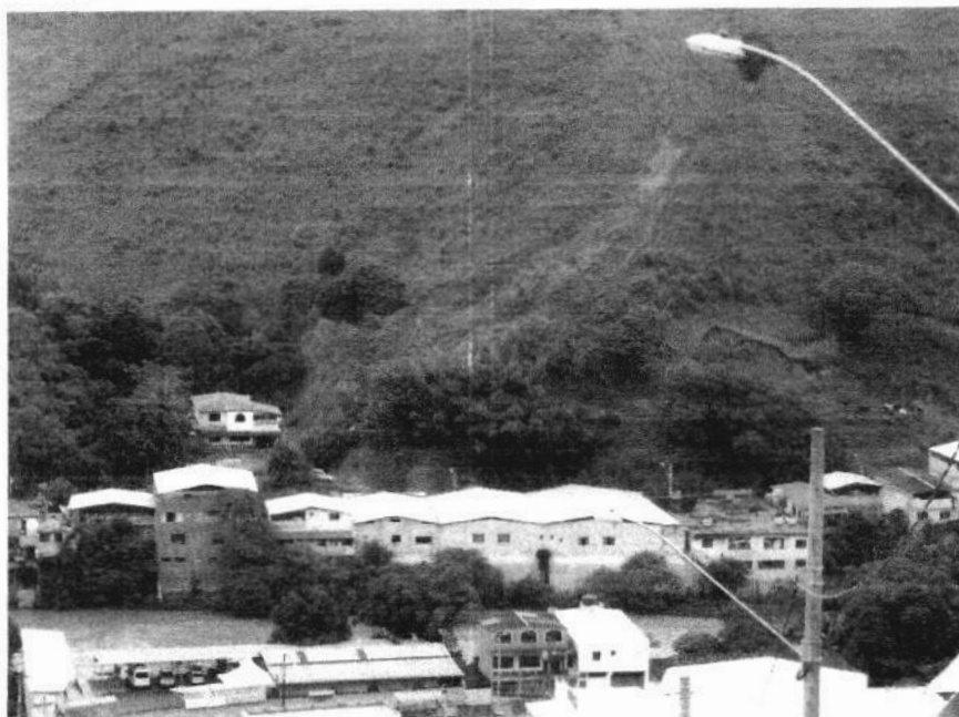
Foto 205 – Domicílios construídos em trecho suscetível a processos de solapamento. Estruturas construídas dentro da área de influência do Rio Piranga. Foto obtida no período seco.
